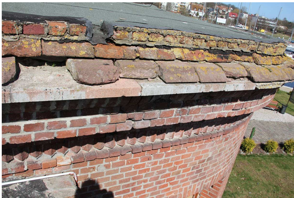
Fot.10. Uszkodzony gzyms piaskowcowo- ceramiczny.
