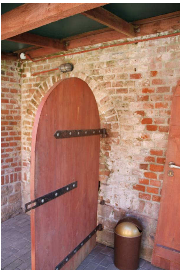
Fot. 6. Tam gdzie ściany ceglane były przemalowane wapnem lub są zachłapane zaprawą, należy powierzchnię potraktować 5-7% kwasem octowym lub mrówkowym następnie zmyć wodą.
