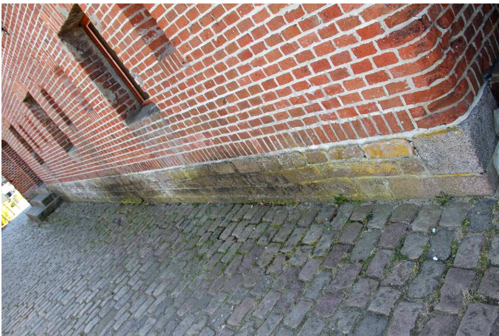
Fot. 2. Zawilgocenie fasady. Widoczne wyraźnie ciemniejsze plamy.
