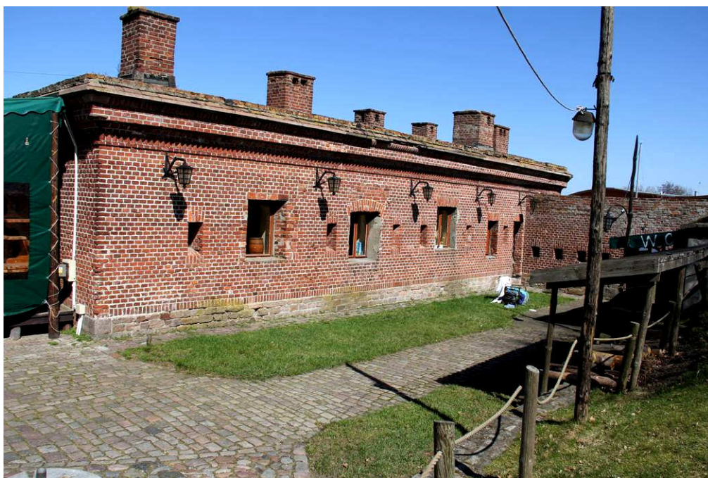
Fot. 3. Widoczne ciemniejsze regularnie występujące na fasadzie plamy przy cokole są efektem podciągania wód gruntowych i zaciekania z dachu, a co za tym idzie porostu alg i mchu.
