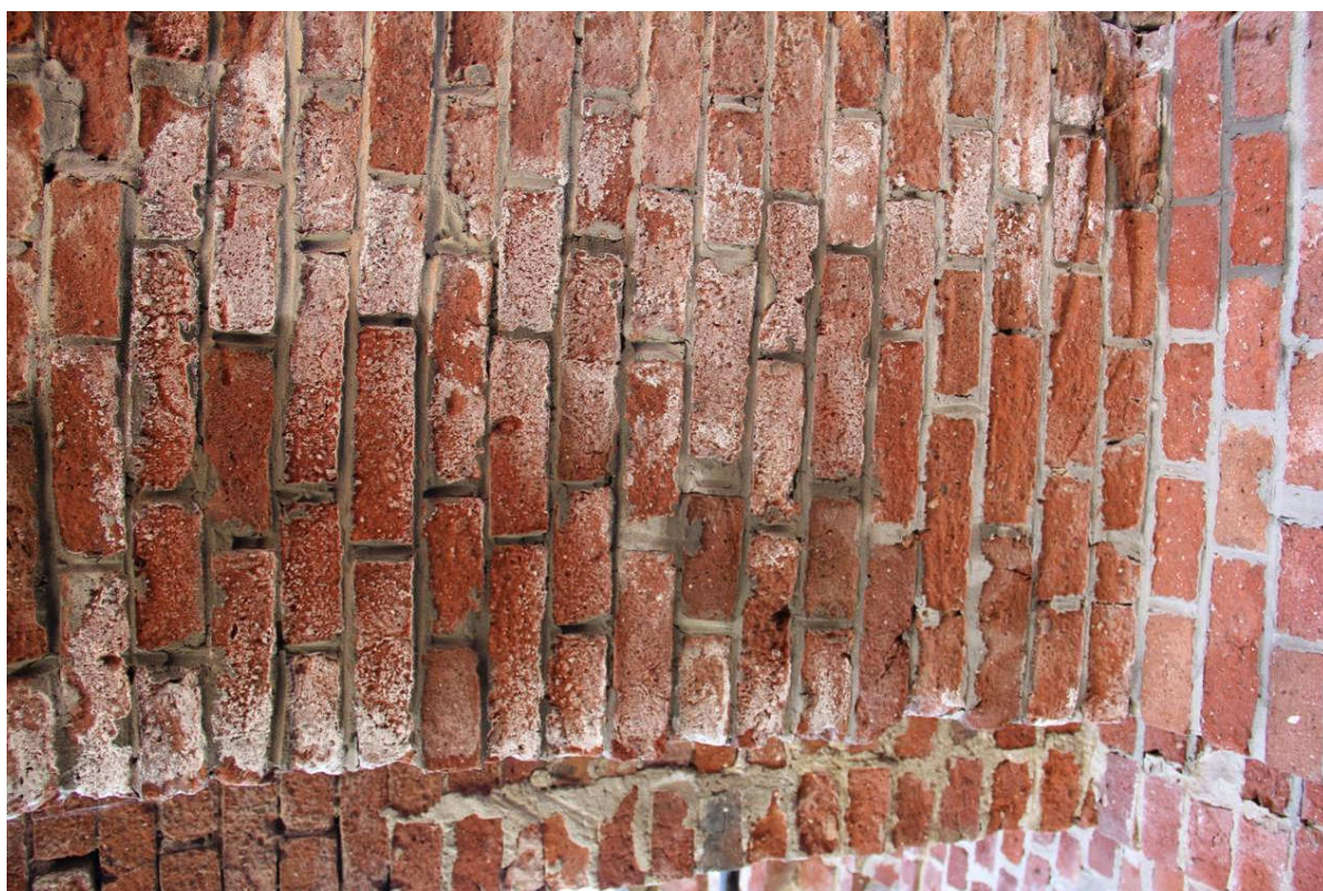
Fot. 5. Grube, kalafiorowate wykwity soli widoczne na powierzchni cegły nad przejściem.
